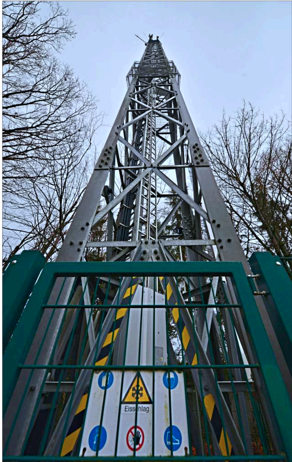
Einen 30 Meter hohen Stahlgitterfunkmast stellt die DFMG Deutsche Funkturm GmbH, eine Tochter der Telekom, in Buch bei Rotthalmünster auf – für besseren Handy-Empfang. Der Bauausschuss hat einstimmig grünes Licht für das Vorhaben gegeben. – Foto: Archiv Schlegel
