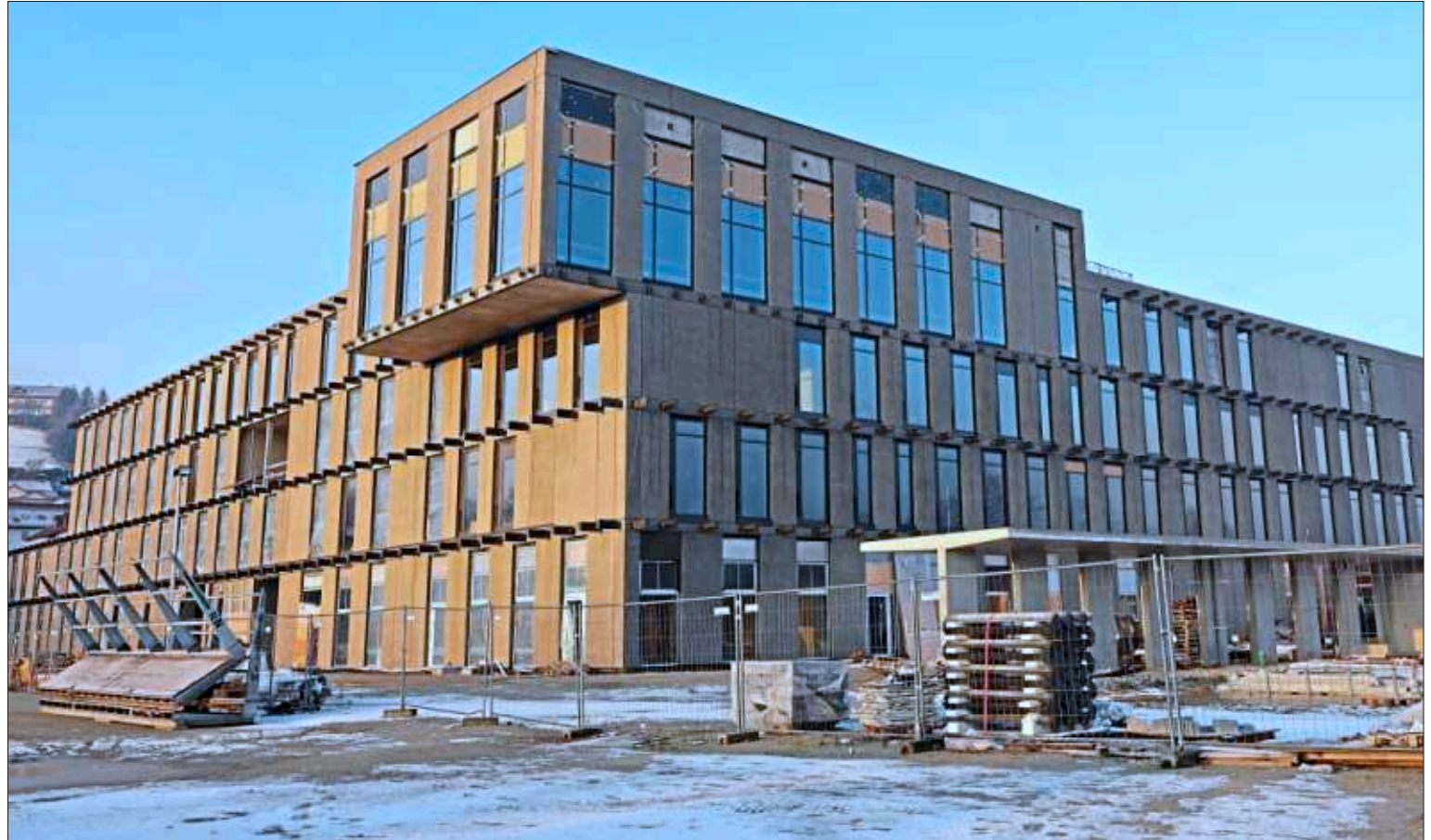
Der Rohbau ist fertig, die Fenster sind drin, und das gestalterische Highlight – der außenliegende Sonnenschutz mit senkrechten Lamellen vor der Sichtbetonfassade – kündigt sich mit den gesetzten Stahlwinkeln bereits an. – Foto: Scholz
