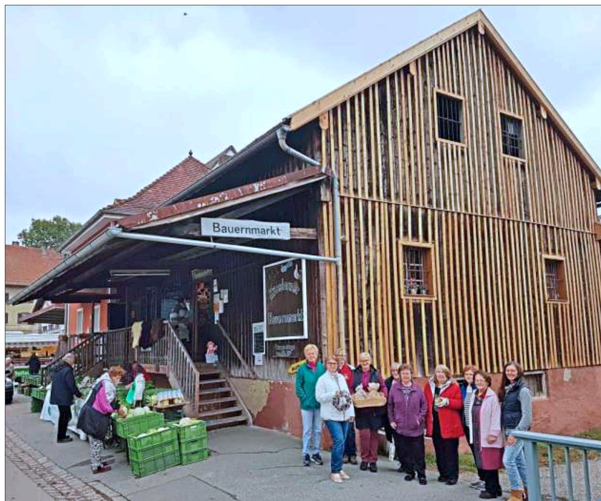
Helpen zusammen: Die Bäuerinnen und Fierantinnen vor der renovierten Giebelseite. Für die Fotos nahmen die Damen ihre Masken kurz ab. – F.: Mühldorfer
