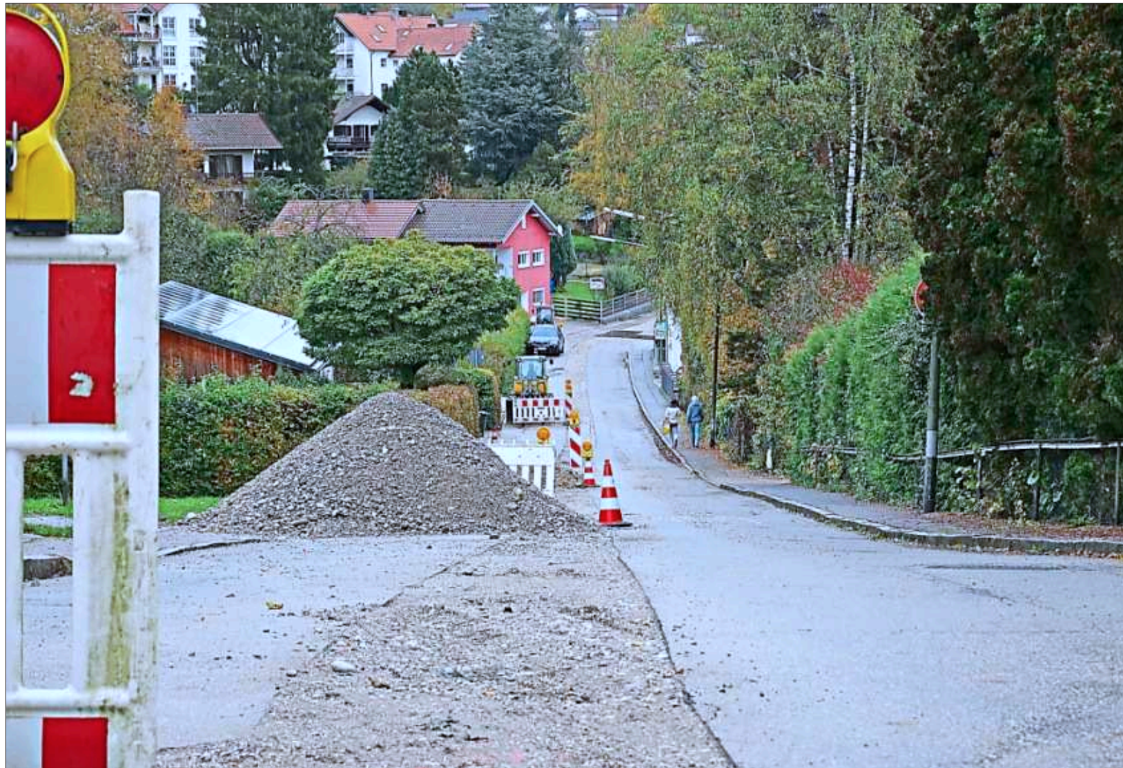
Der Zweckverband Wasserversorgung Ruhstorfer Gruppe hat in den vergangenen Wochen und Monaten viele Baustellen angefangen und zum Teil auch bereits abgearbeitet. Eine davon ist die Sanierung der Rohre am Seilerberg in Bad Griesbach. – Foto: Gerleigner
